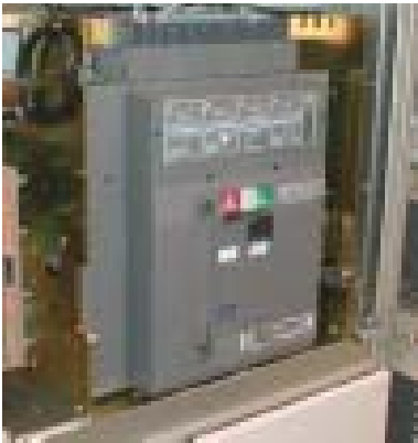
Air Circuit Breaker Emax - E3
